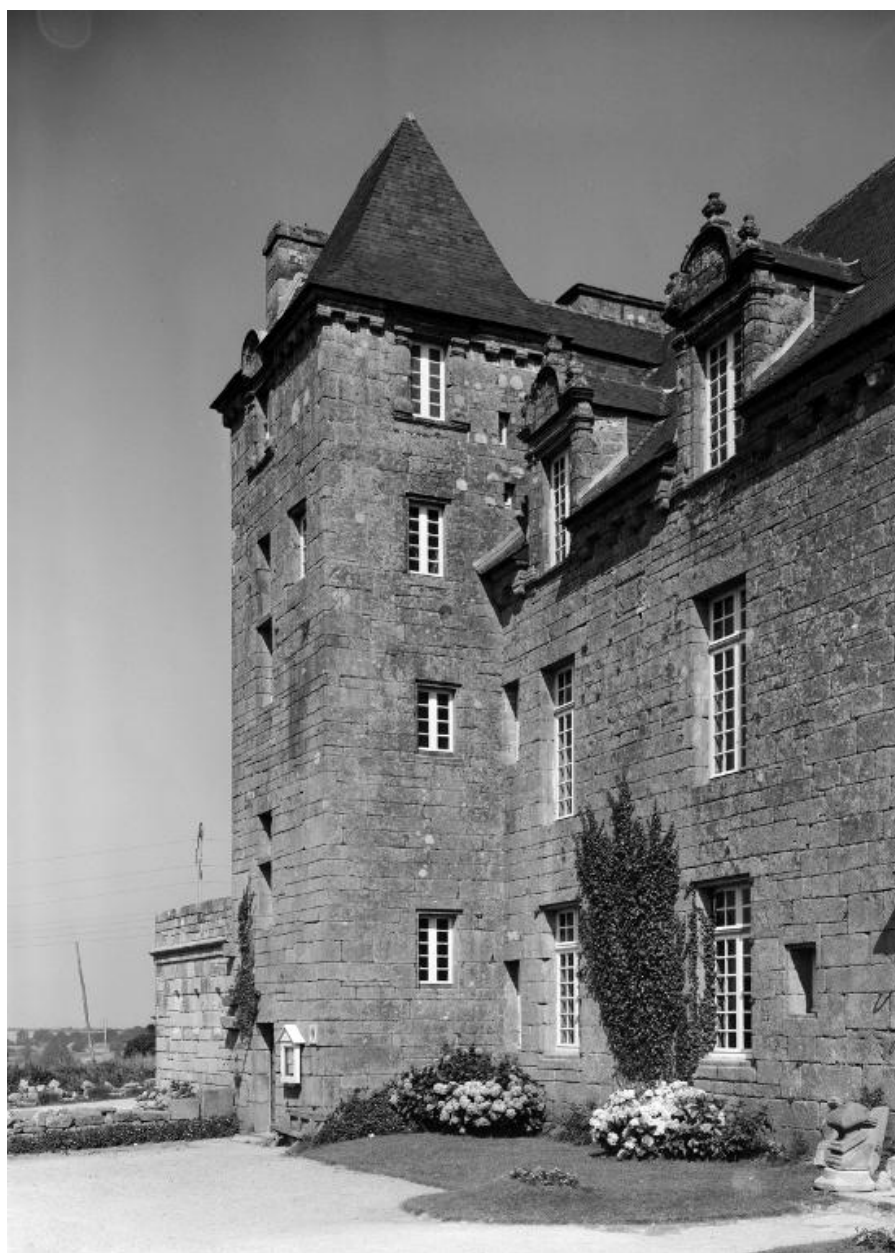
Face est de la tour carrée au sud-ouest
