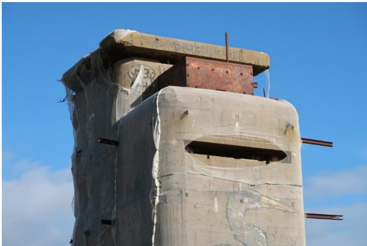
Vue générale du bunker - poste de direction de tir depuis le sud-ouest : partie sommitale
