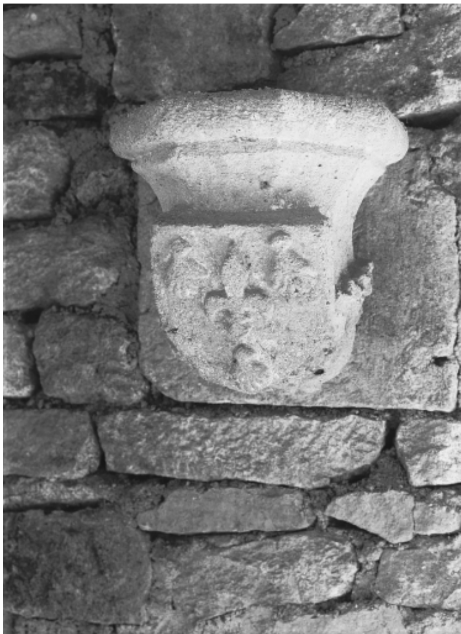
Chapelle, mur du chevet, console nord : détail du blason
