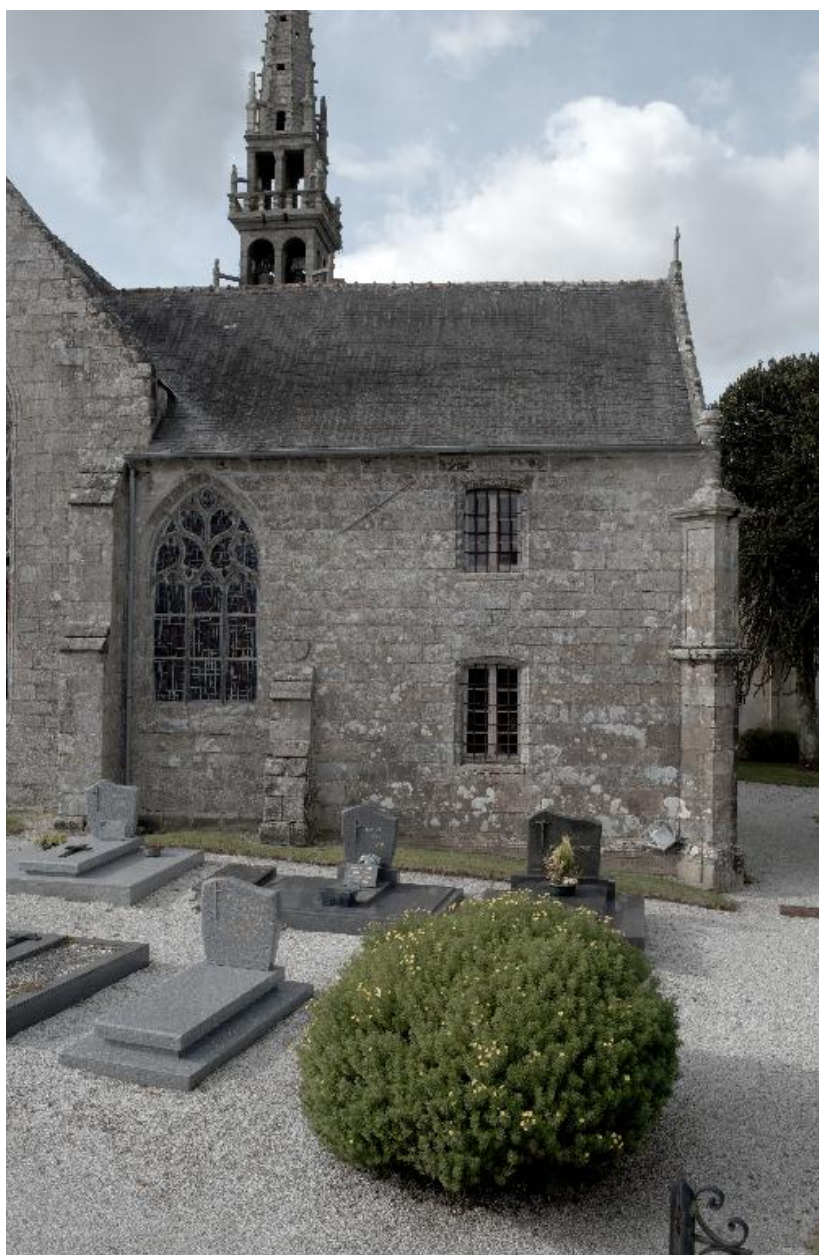
Vue de la sacristie de l'église
