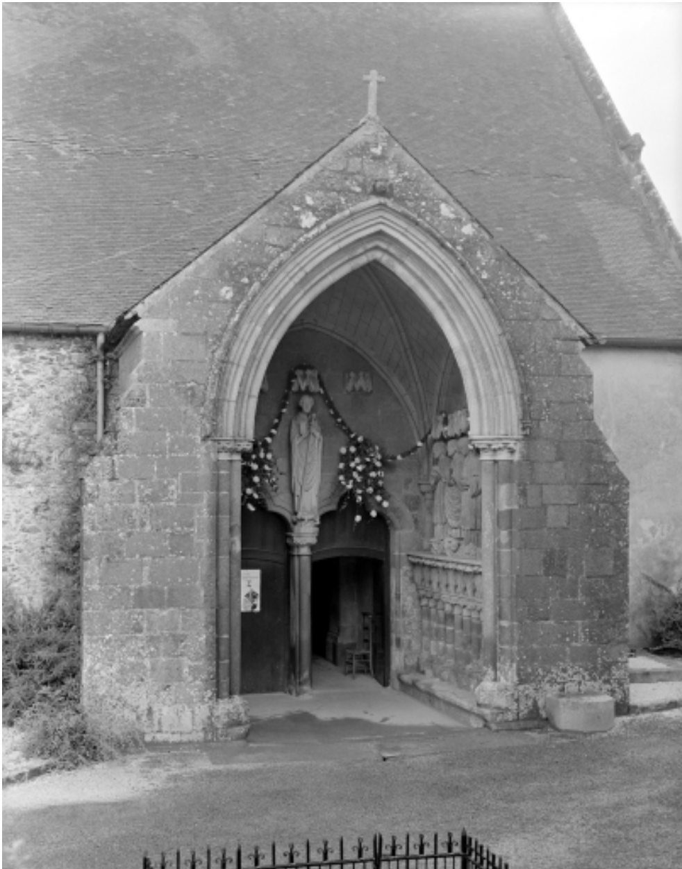
Elévation nord, porche : vue générale
