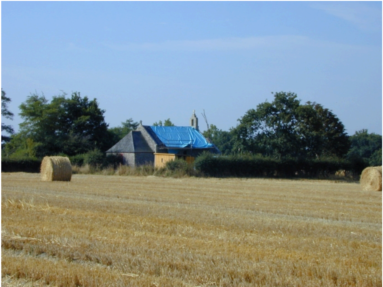
Vue de situation nord-est
