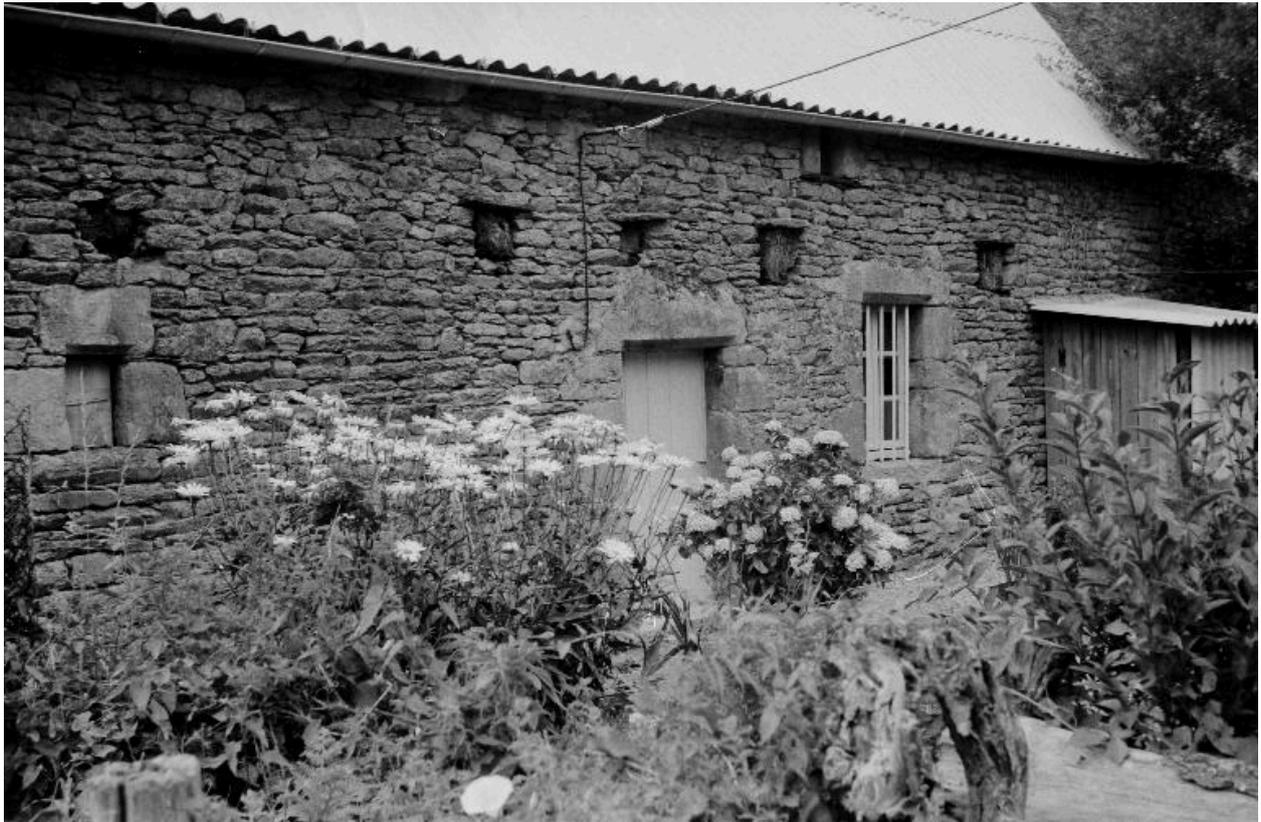
Ferme 43 : chaque about de poutre qui soutient le plancher du grenier est protégé de l'eau par une plaque de schiste, appelé larmier (état en 1969)
