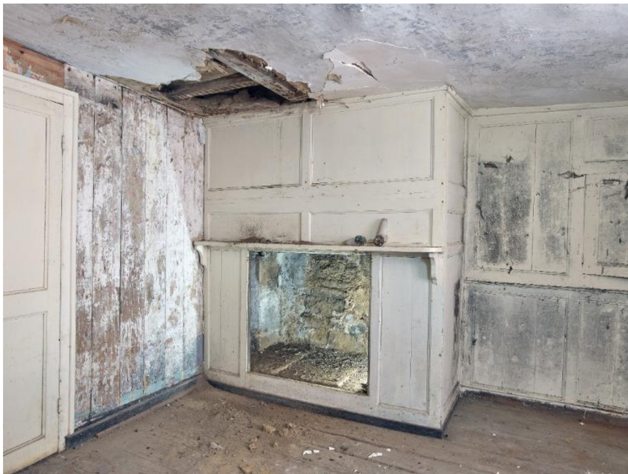
Cheminée masquée derrière des lambris, au rez-de-chaussée du bâtiment nord.
