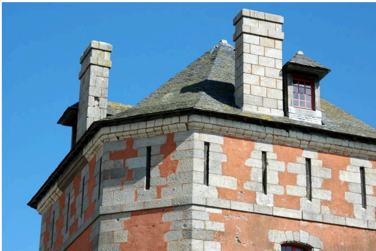
Vue de la Tour Vauban : détail de la toiture
