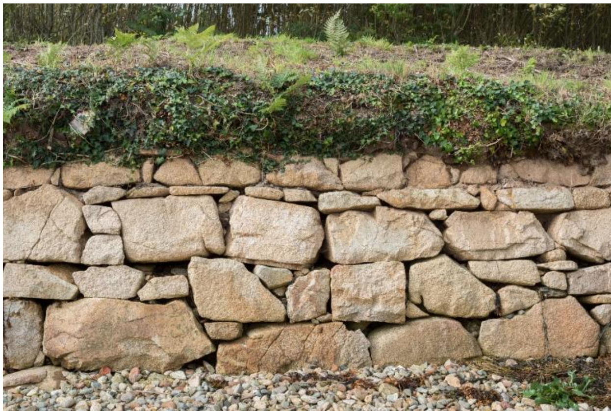
Mur de soutènement avec un travail en couches, sur la rive ouest de l'anse de Pellinec
