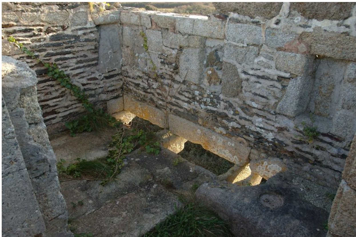
Roscanvel, pointe de Cornouaille : tour-modèle n° 1, mâchicoulis ou créneaux de pied de la bretèche ouest
