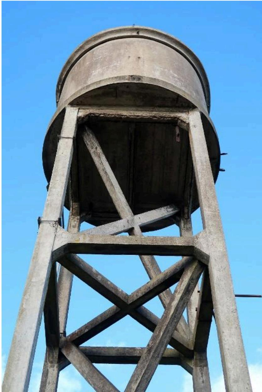
Vue de détail de la partie sommitale : réservoir. Le réservoir cylindrique repose sur une charpente en béton armé
