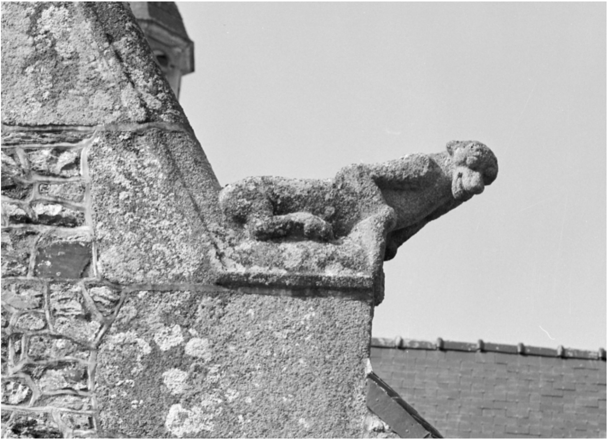
Pignon est, détail crossette, côté nord
