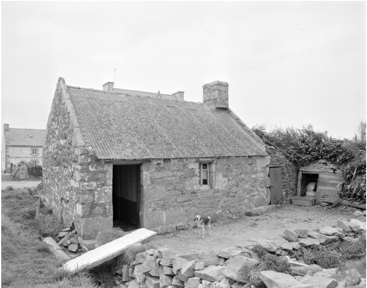
Elévation antérieure du logis et de sa crèche en appentis, vue prise du chemin menant au village. (1977)
