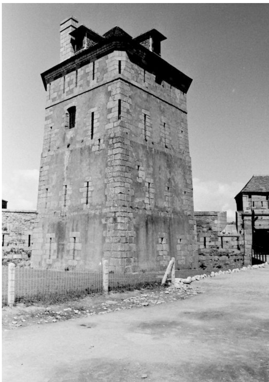
Vue de la tour Vauban en 1967
