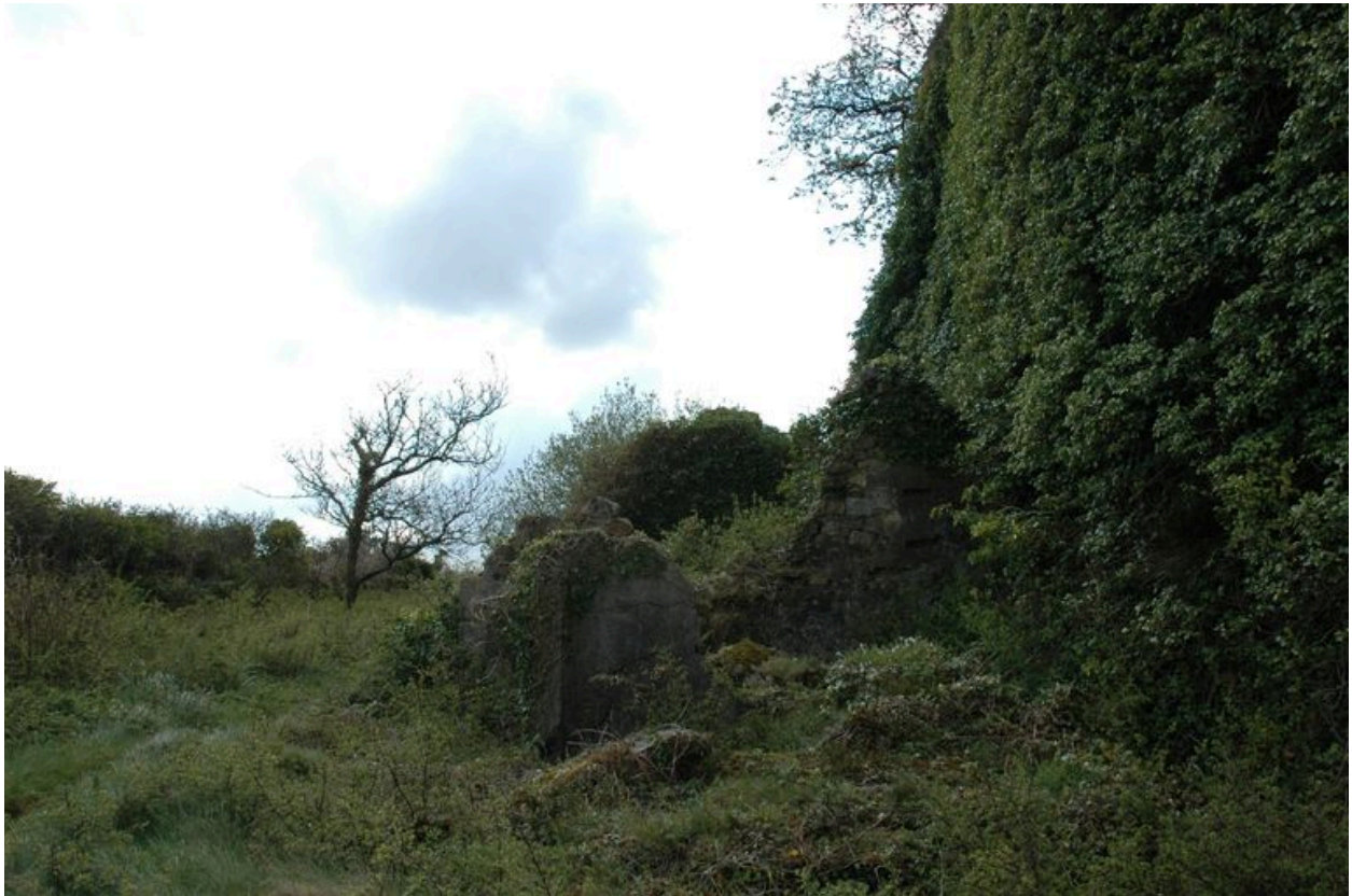
Vue de la pointe des Espagnols : petit bâtiment ruiniforme en moellons
