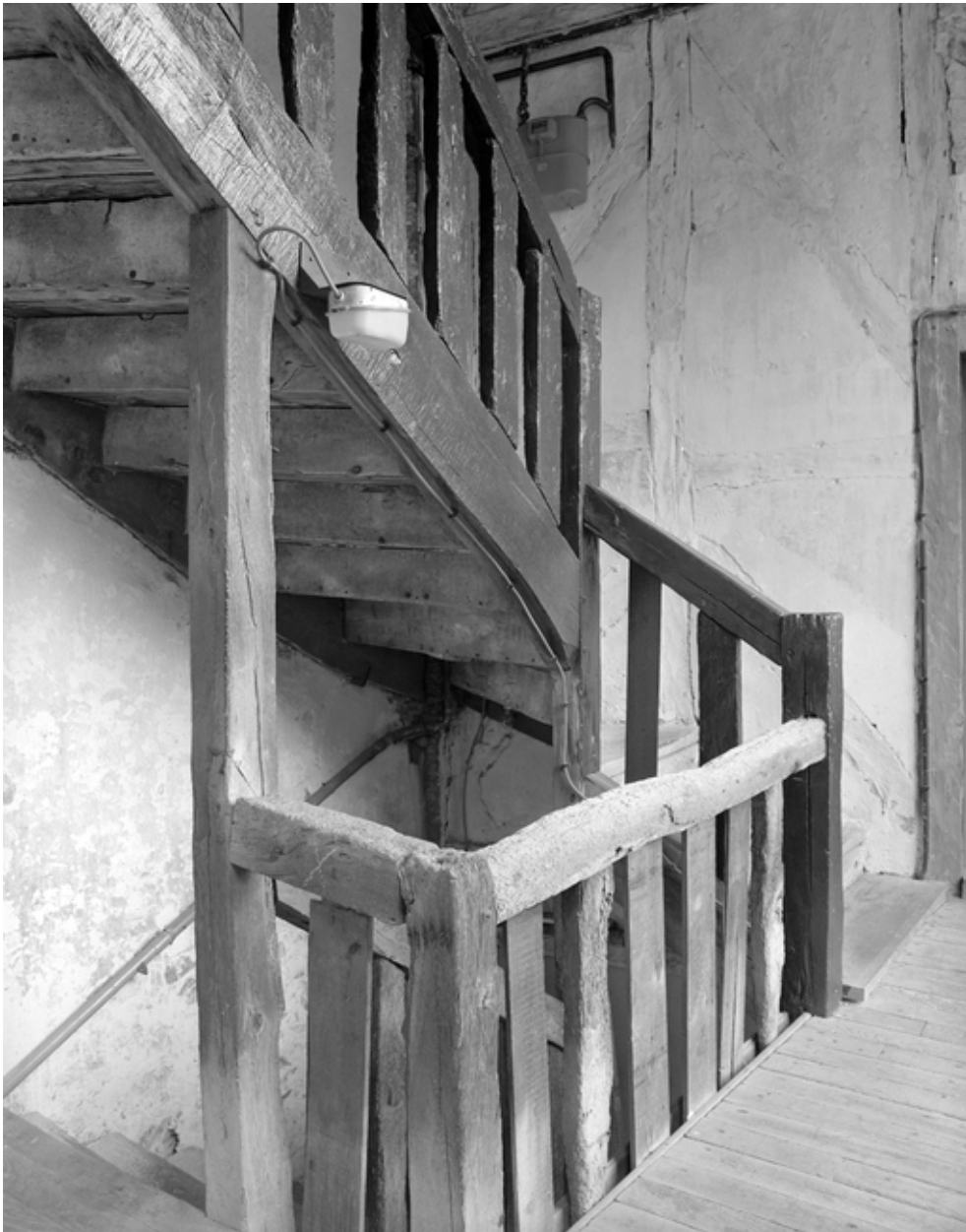
Escalier de l'aile gauche, vue générale.
