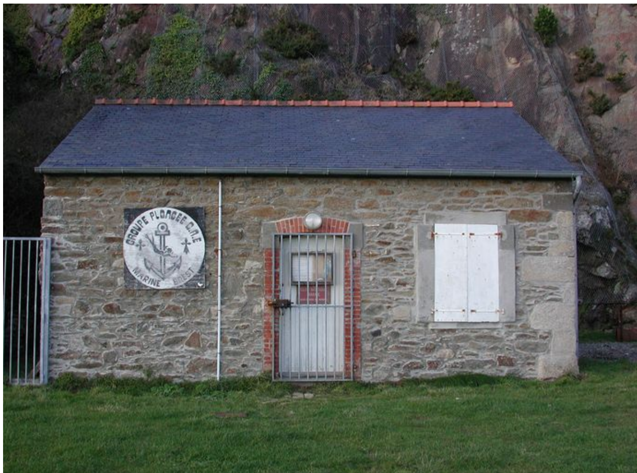
Vue du fort du Mengant : bâtiment non identifié
