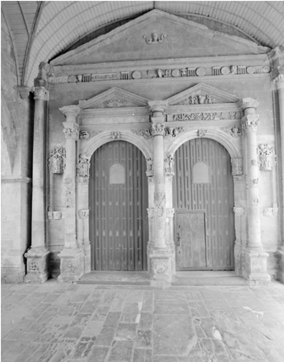
Porche ouest, porte principale
