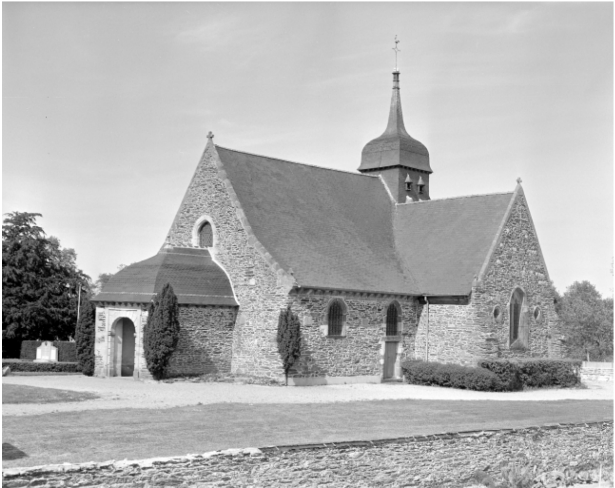
Elévation Sud-Ouest : vue générale (état en 1994)
