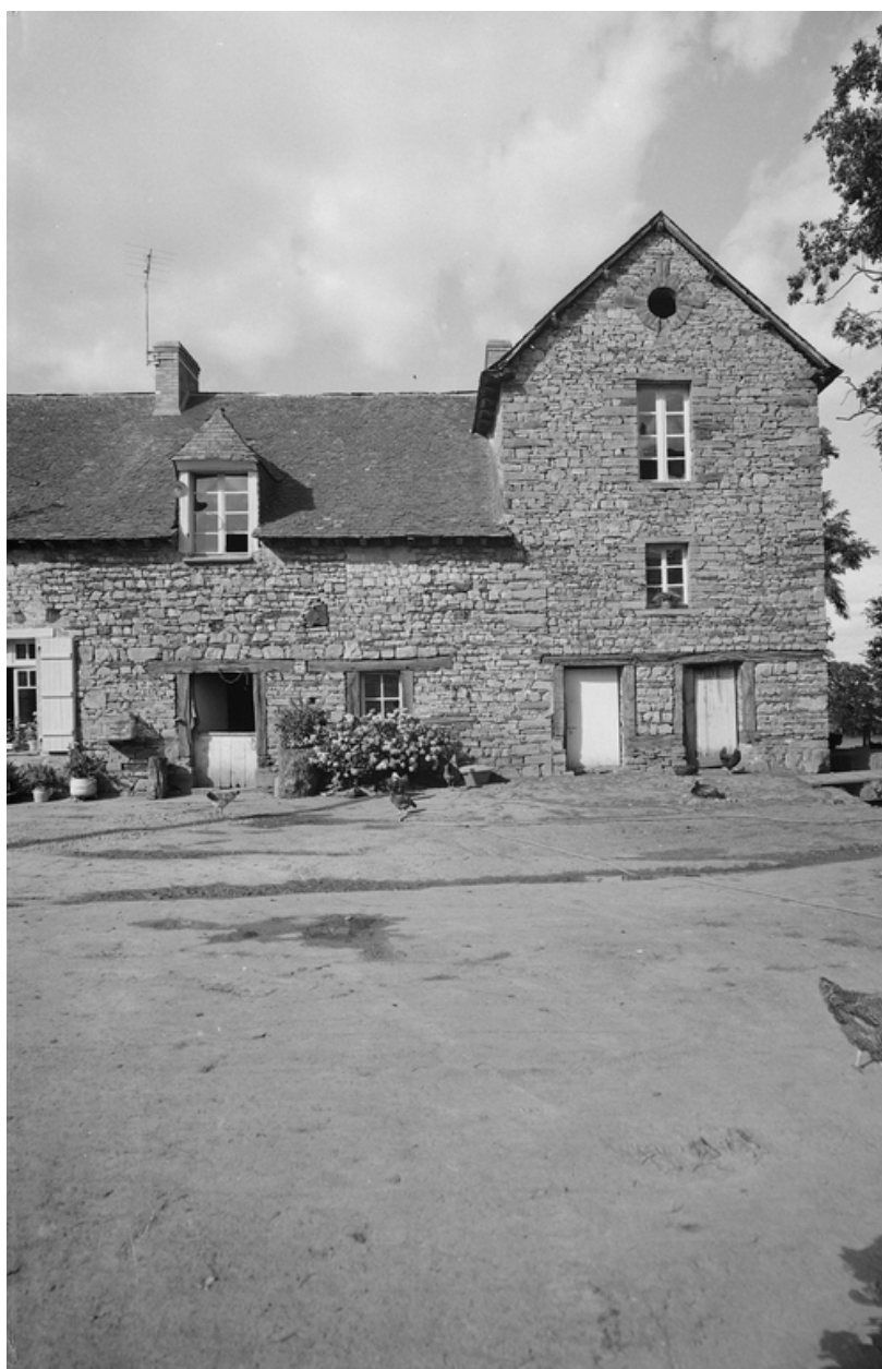
Dépendances, aile nord façade sud.
