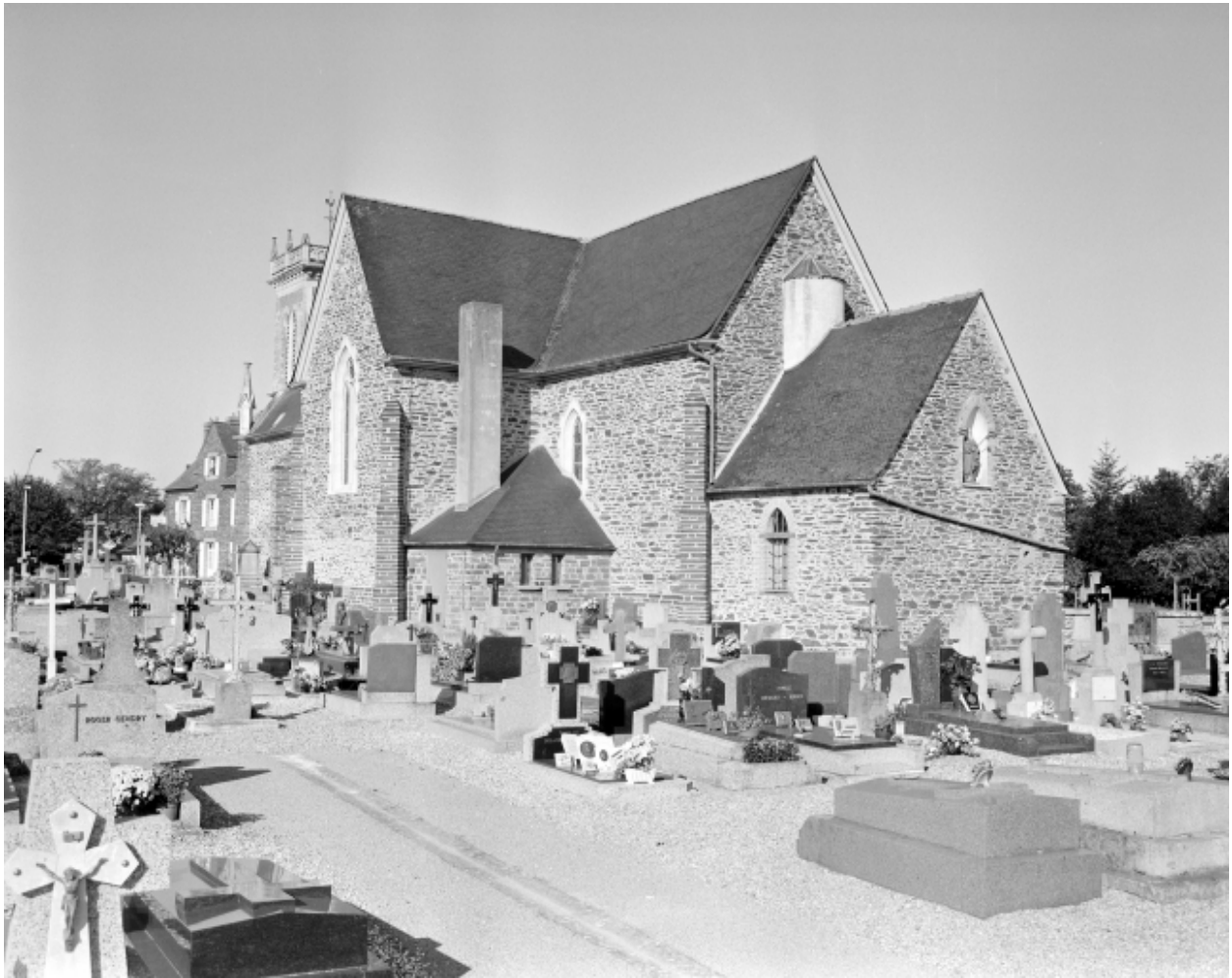
Elévation Est : vue générale
