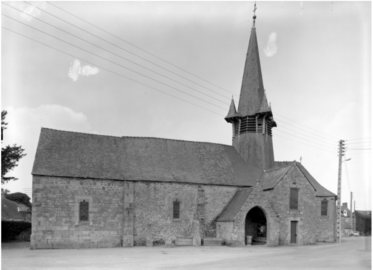
Elévation sud : vue générale
