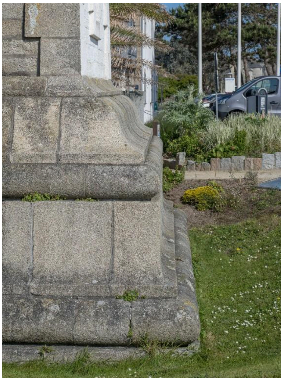
Soubassement carré du phare : mise en oeuvre du granite, corniche en douce
