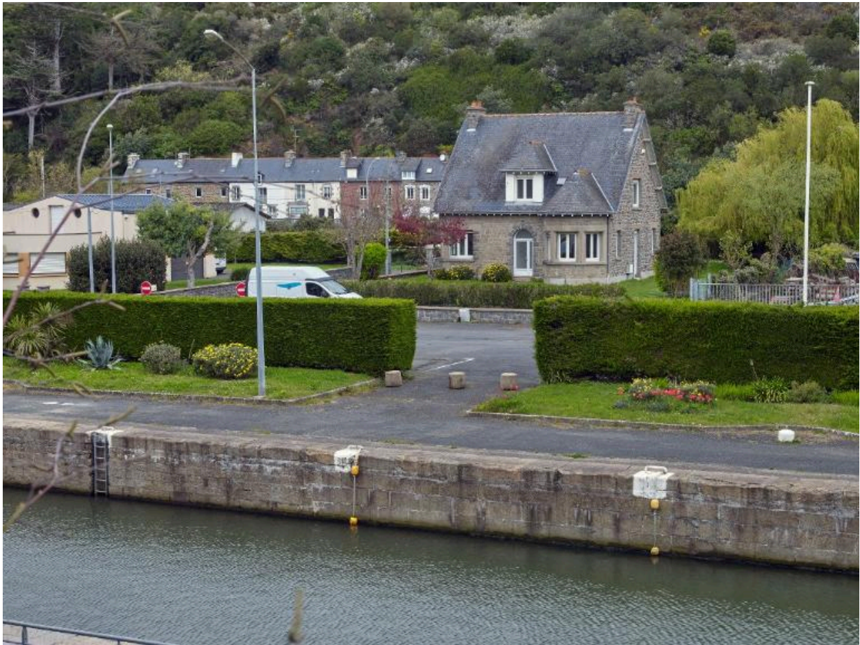
Vue de situation des locaux régionaux sur le site de l'écluse du port du Légué
