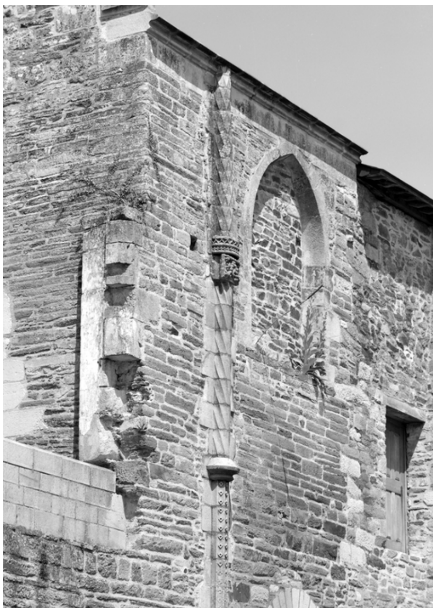
Elévation sud de la chapelle, détail du tuyau de descente.
