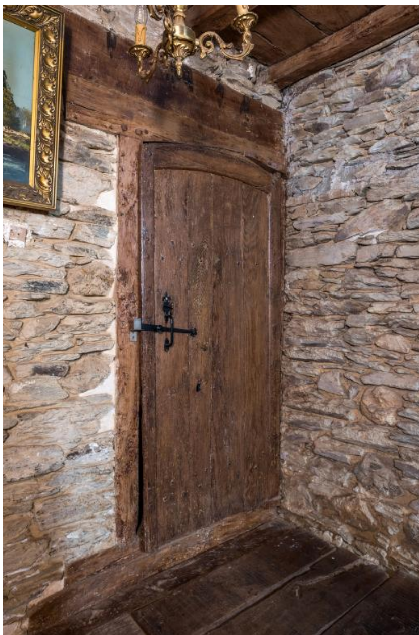
Logis 1774. Repos de l'escalier. Porte d'accès à l'étage de l'appentis posterieur
