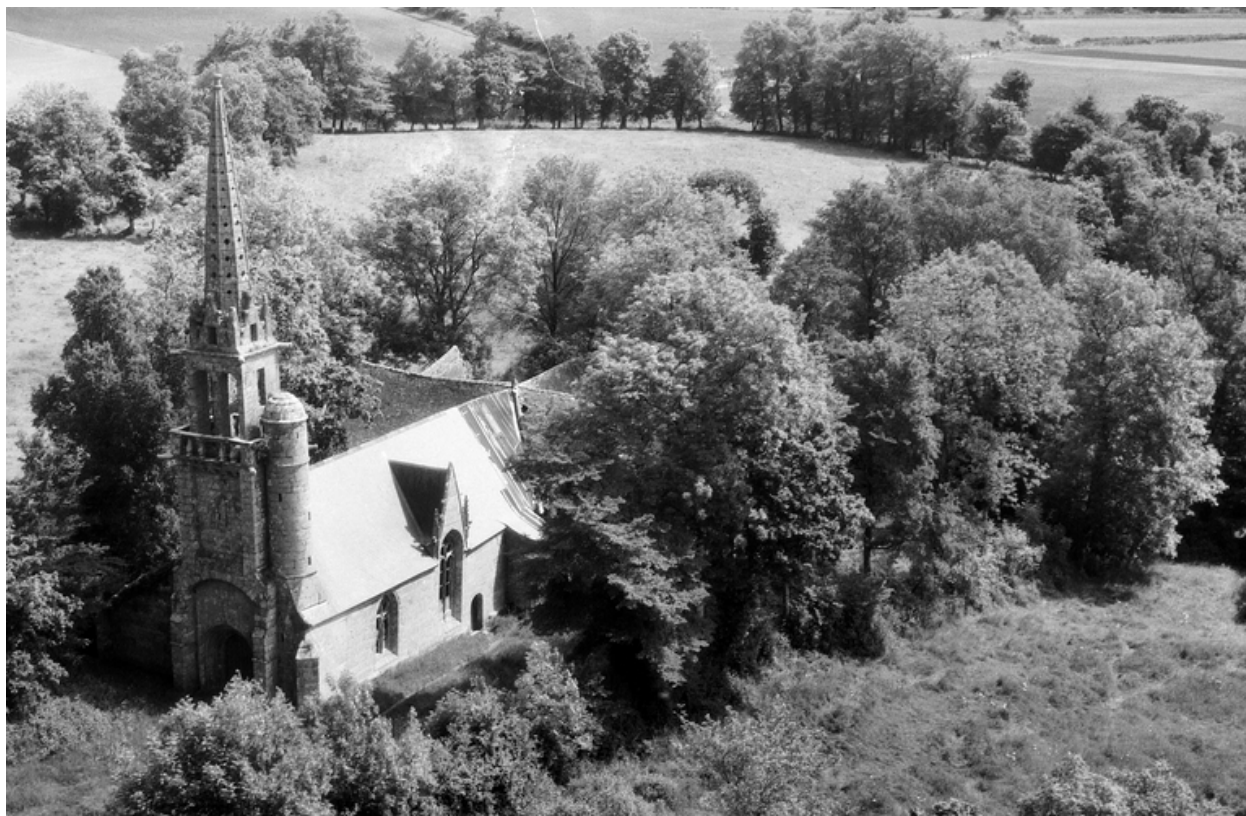
Vue générale prise du sud ouest
