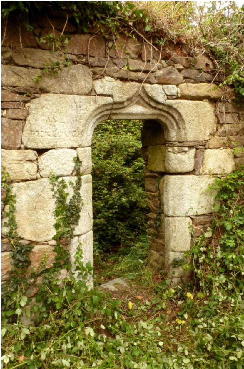
Ancien logis (?) daté 1780 devenu creche. Détail de la porte en anse de panier. (2021)
