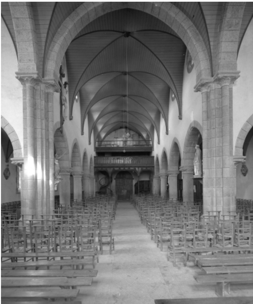
Collorec, église paroissiale Notre-Dame : vue générale intérieure d'est en ouest, état en 1967
