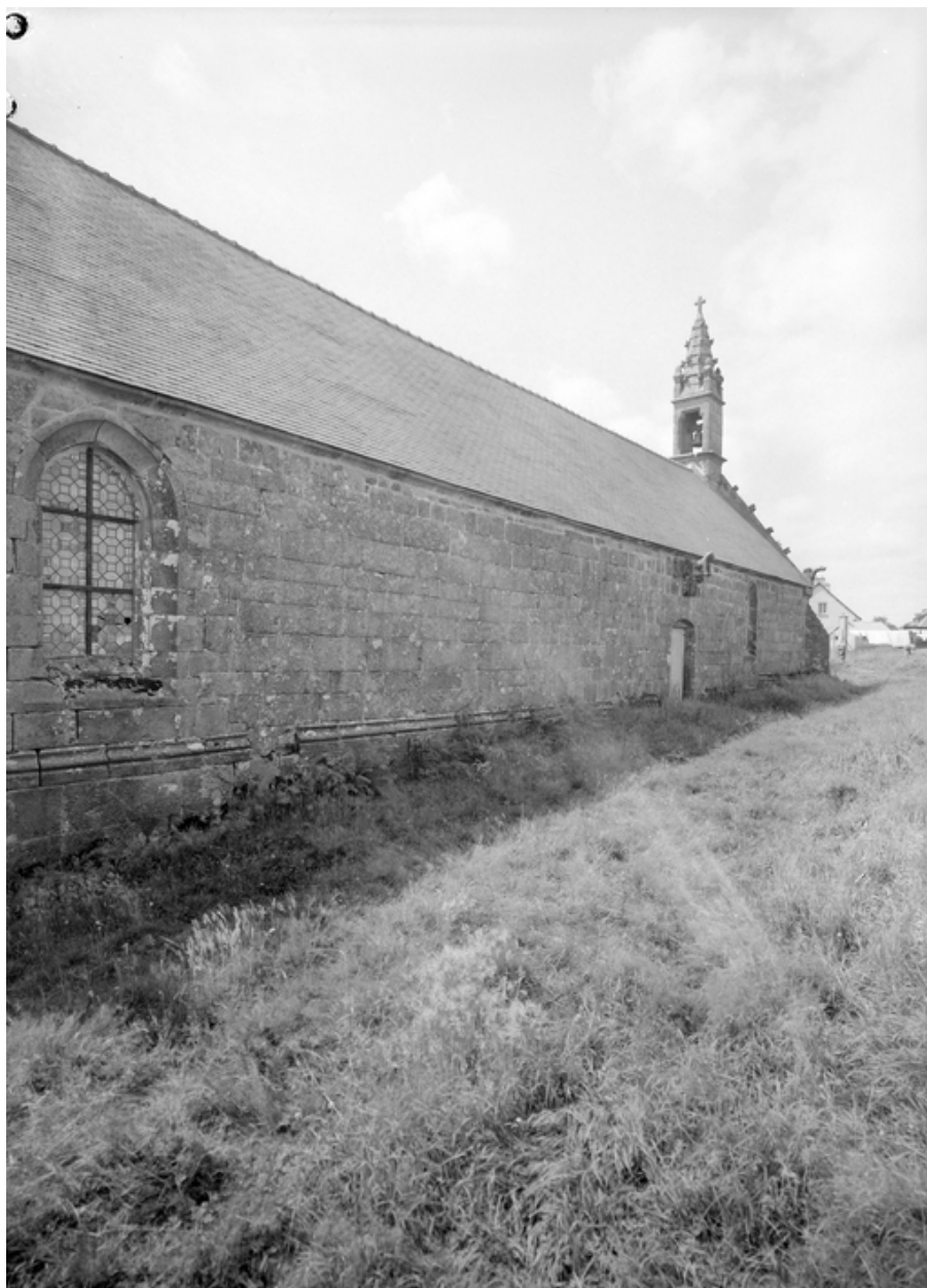
Face nord : vue générale
