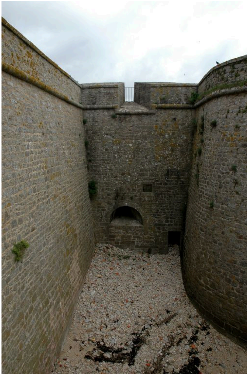
Vue de la citadelle de Port-Louis : embrasures nord protégées par l'orillon du bastion Dumourier et flanquant la porte du corps de place
