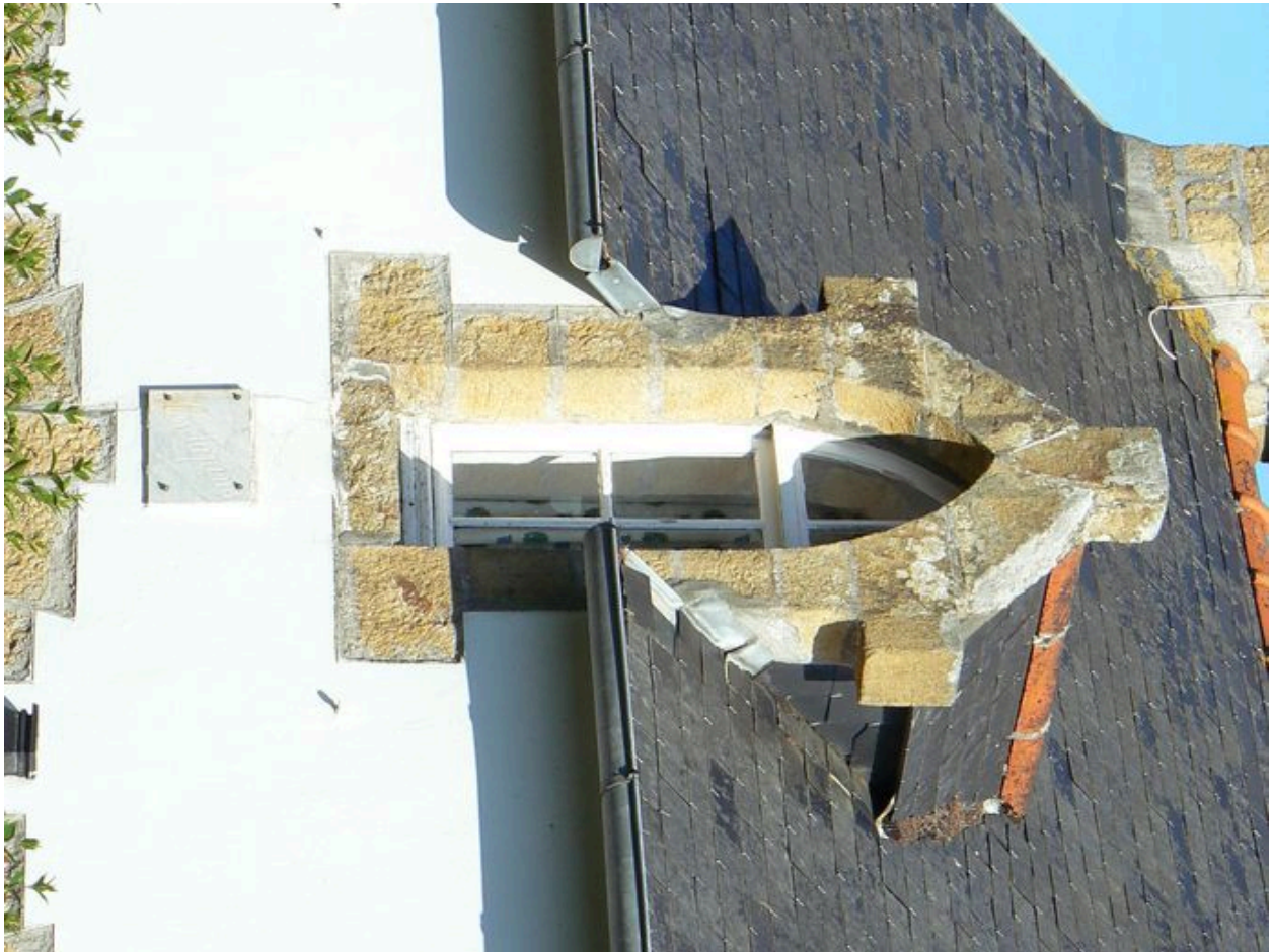
Fenêtre de l'étage de la villa Les Sapins
