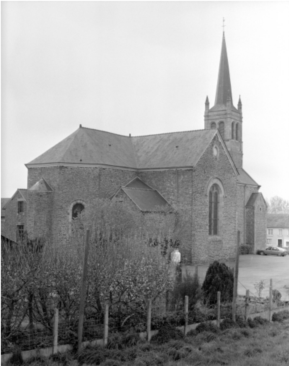
Elévation Sud-Ouest : vue générale
