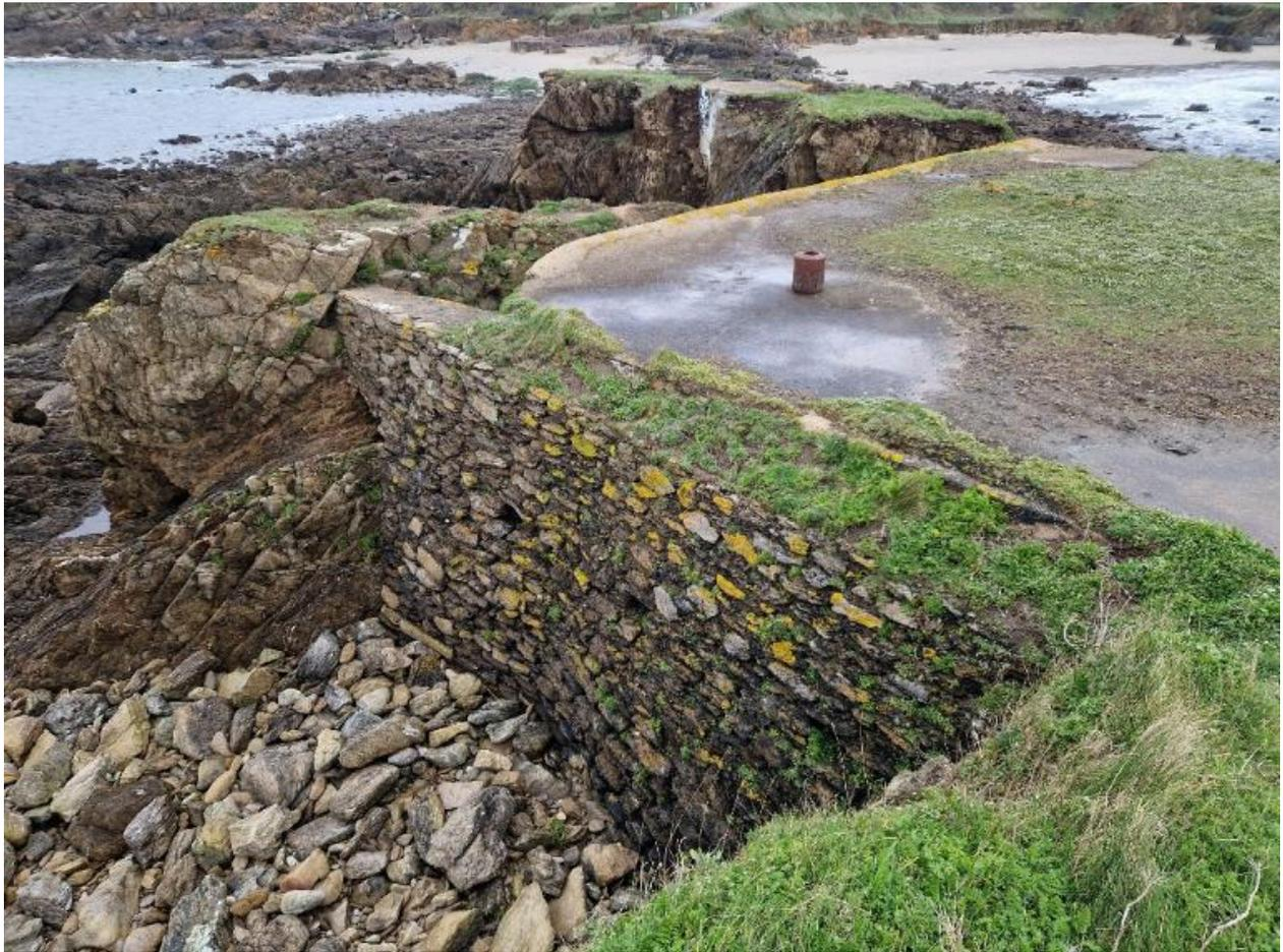
Vue générale. La maçonnerie de moellon masque le bunker - abri à l'ouest. A droite, la dalle de couverture du bunker : le conduit du périscopes émerge de la dalle de couverture
