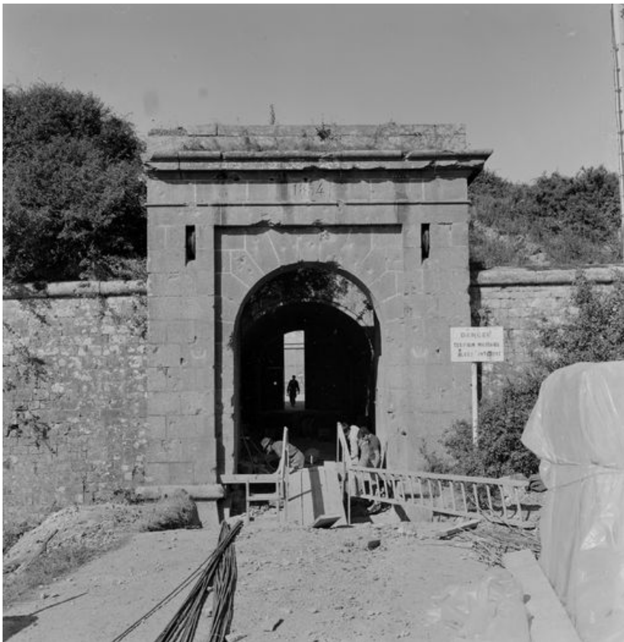
Vue du réduit de Quélern en 1969 : porte d'entrée monumentale datée 1854
