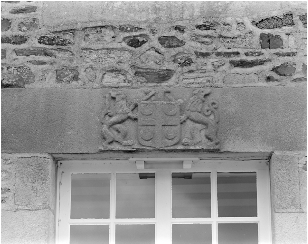
Détail fenêtre à l'étage, avec blason
