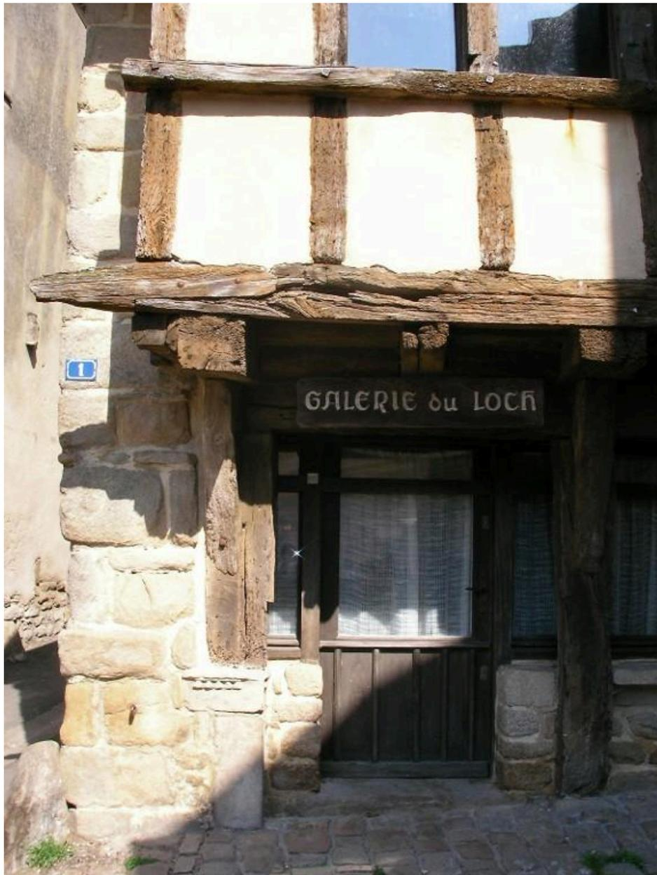
Plusieurs remaniements sont visibles : reprise en pierres sous le poteau de gauche, raccord sur la sablière.
