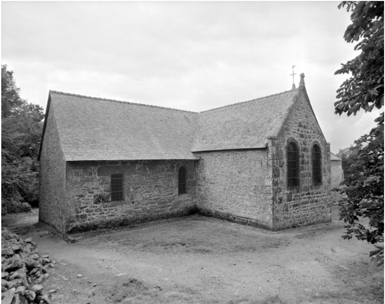
Elévation Nord-Est : vue générale
