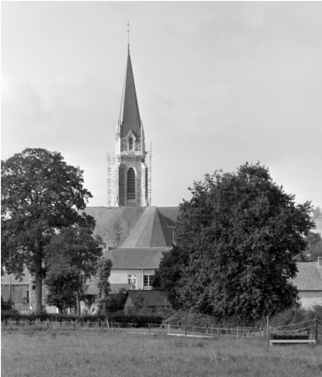
Elévation est, clocher
