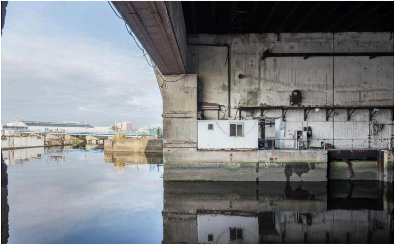
Vue du panorama vers le nord depuis l'alvéole sud : le Scorff et le pont Gueydon. Le linteau en béton armé situé au-dessus de l'entrée de l'alvéole n'a pas la même épaisseur que le mur de soutien
