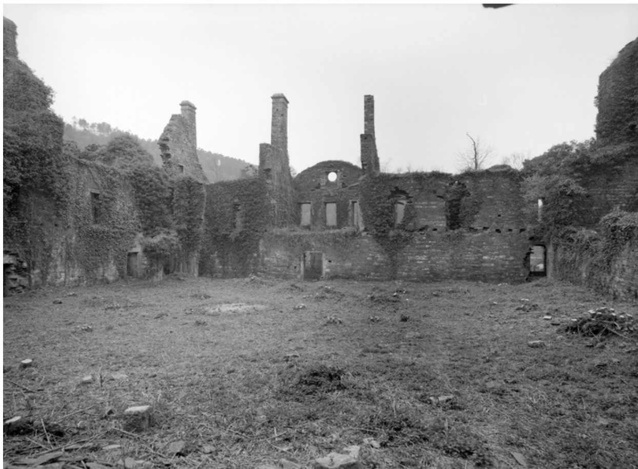
Cloître : vue intérieure prise de l'Est, vers le logis abbatial (état en 1977).
