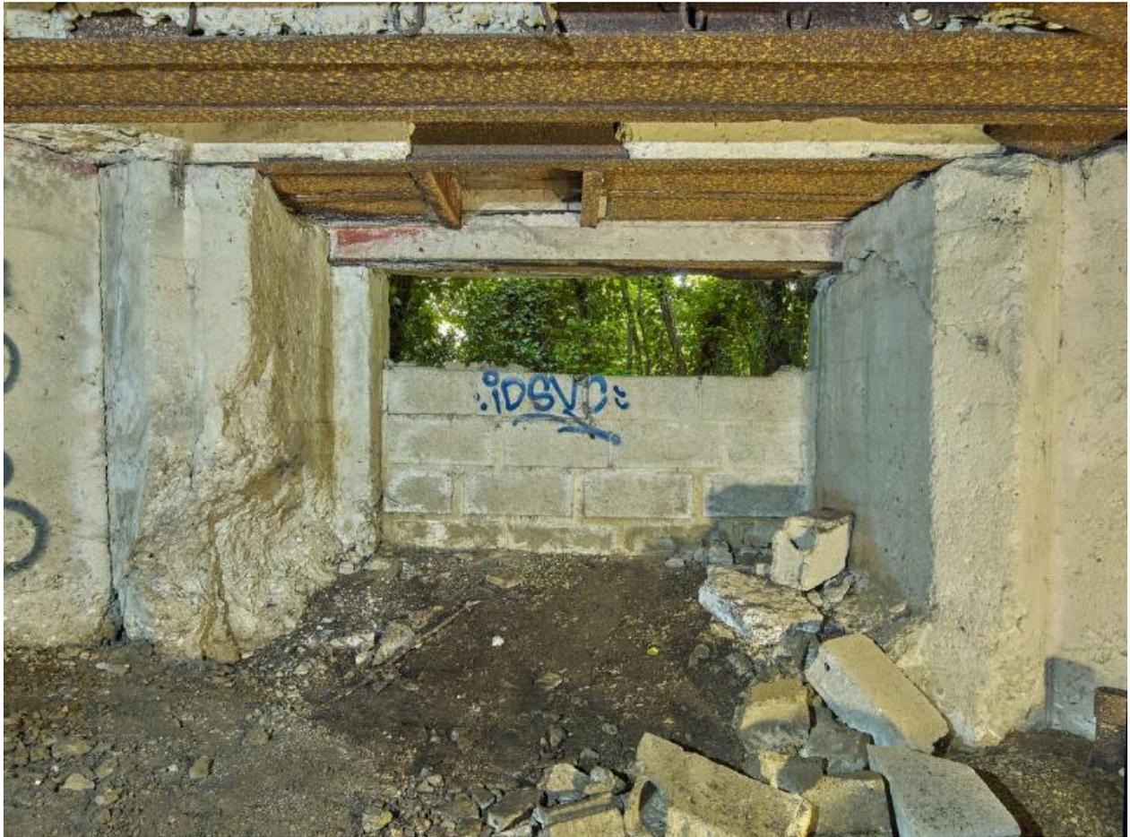
Vue de la chambre de tir (vers l'embrasure) : au centre, embrasure rectangulaire (partiellement murée par des parpaings) ; au plafond, emplacements des bouches d'aspiration des fumées de tir. La chambre de tir semble avoir subi une explosion interne
