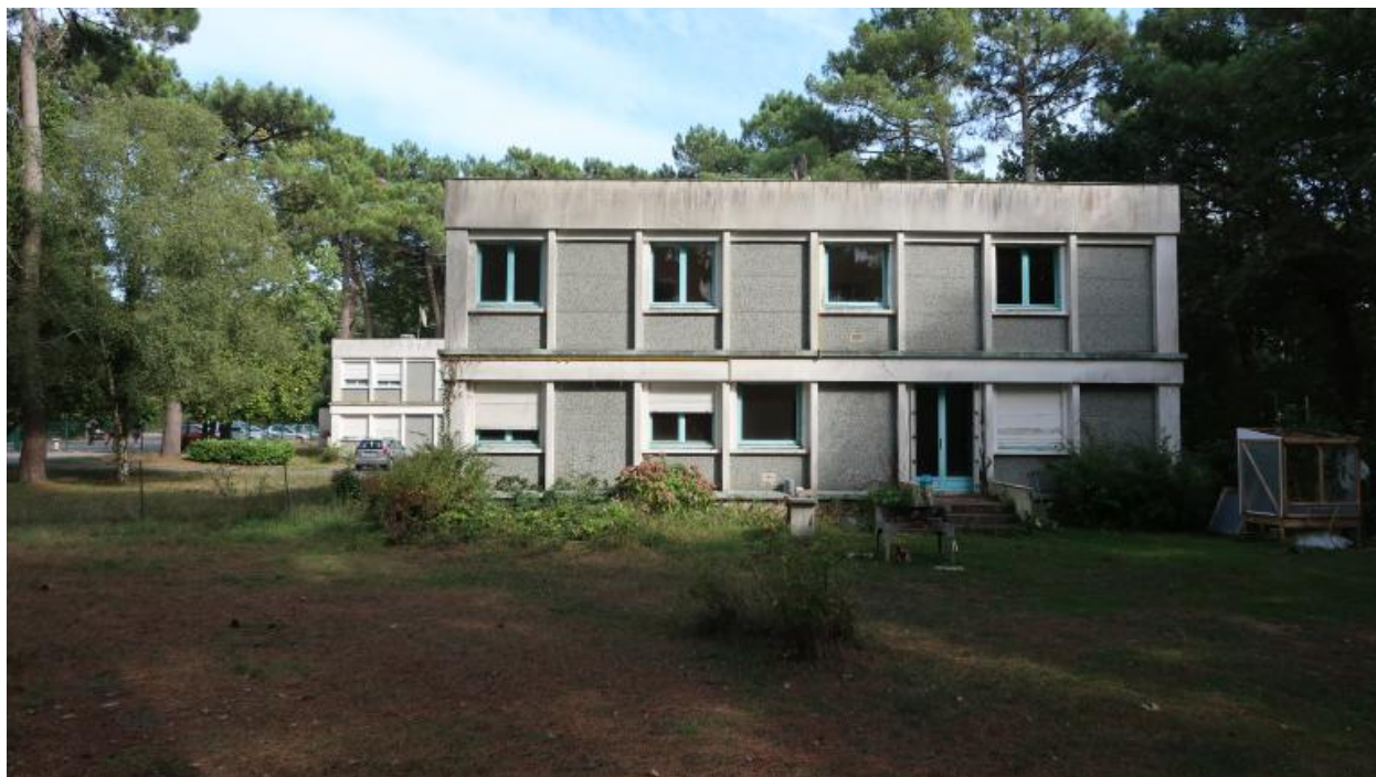
Logement A (ou 1), façade ouest. A l'arrière plan, logements B (ou 2). Yves Guillou, architecte, 1969.
