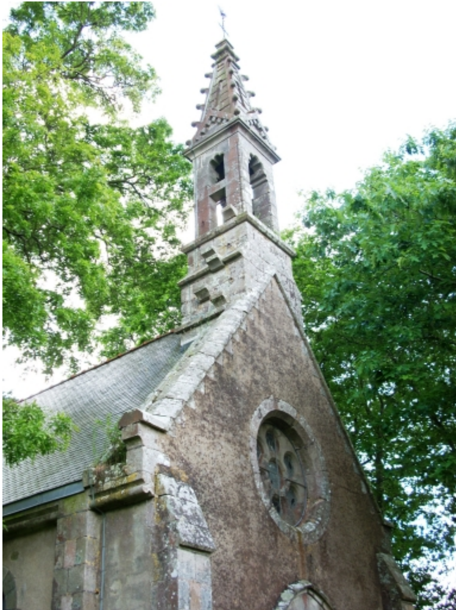
Quimper, chapelle de Cuzon : détail clocher depuis le nord-ouest
