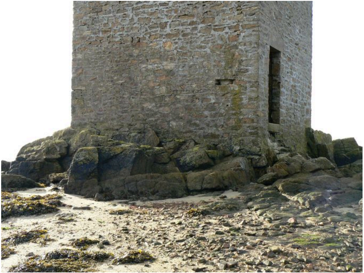
Vue de la base de la tour de Ténéro
