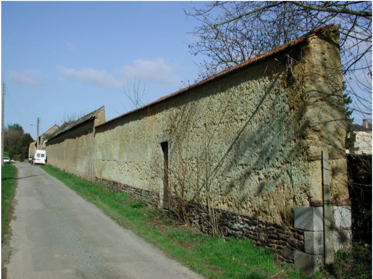
Mur de clôture en terre
