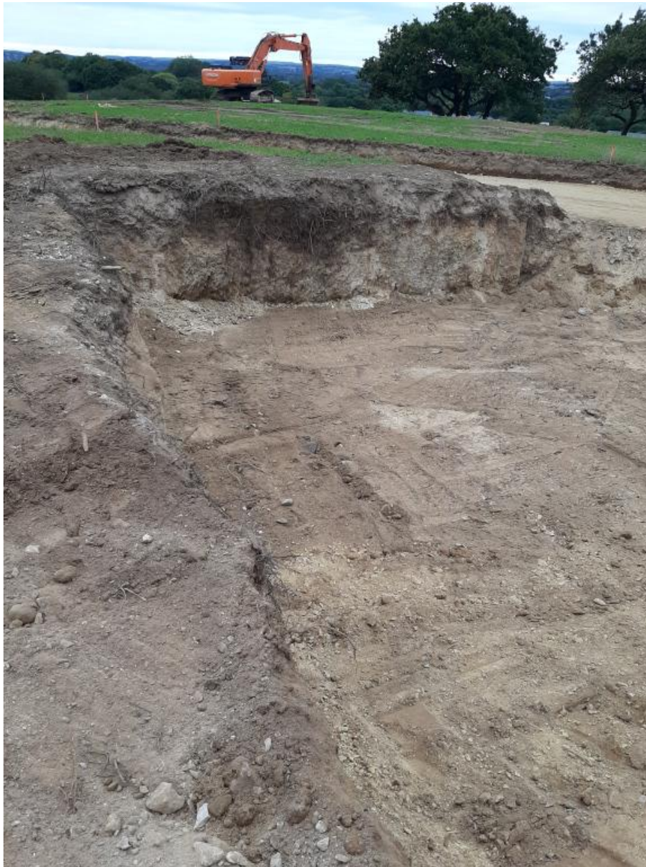
Vue de la fouille après déconstruction (4 octobre 2022)
