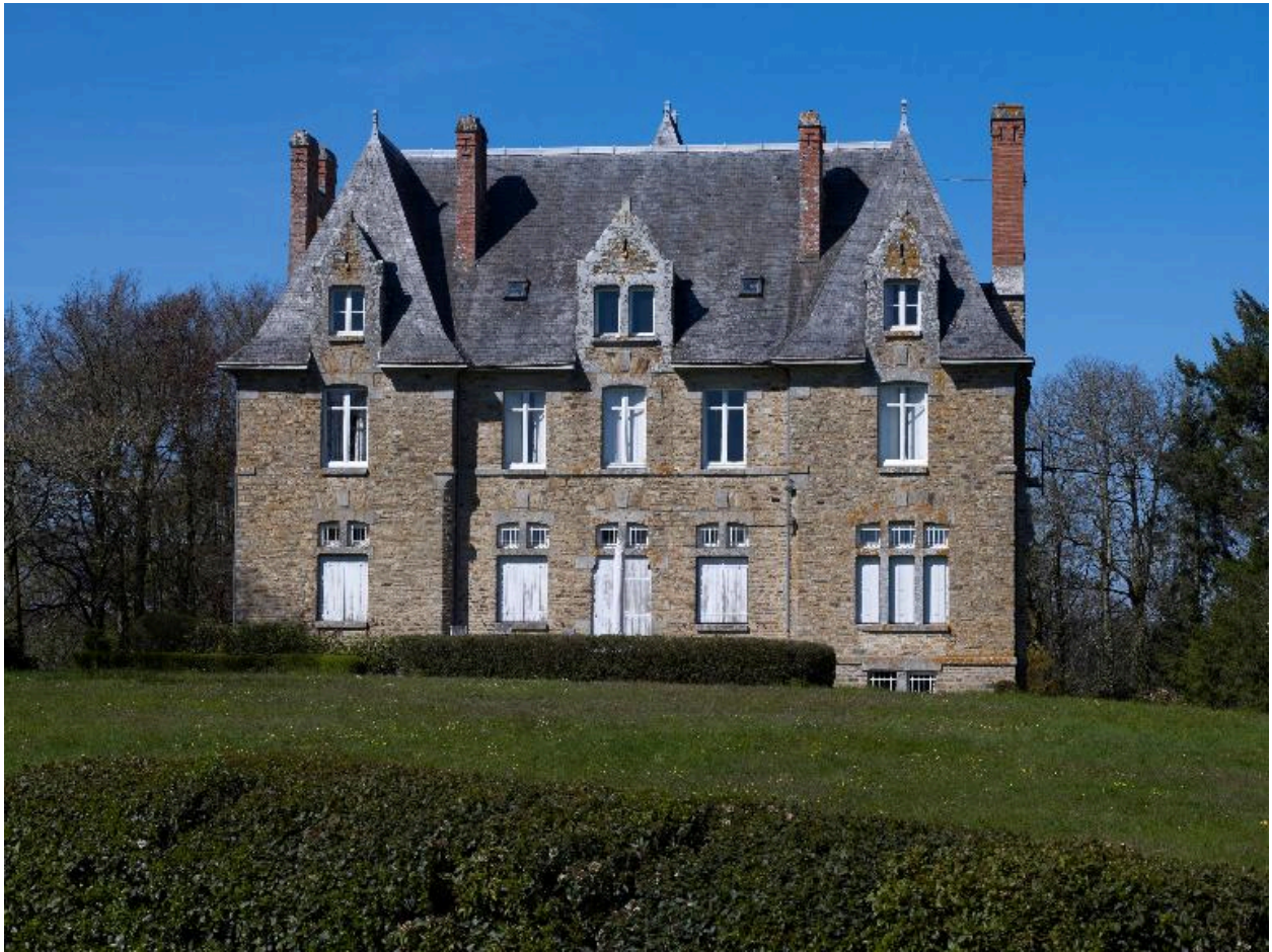
Château : vue générale prise du sud (état en 2015)
