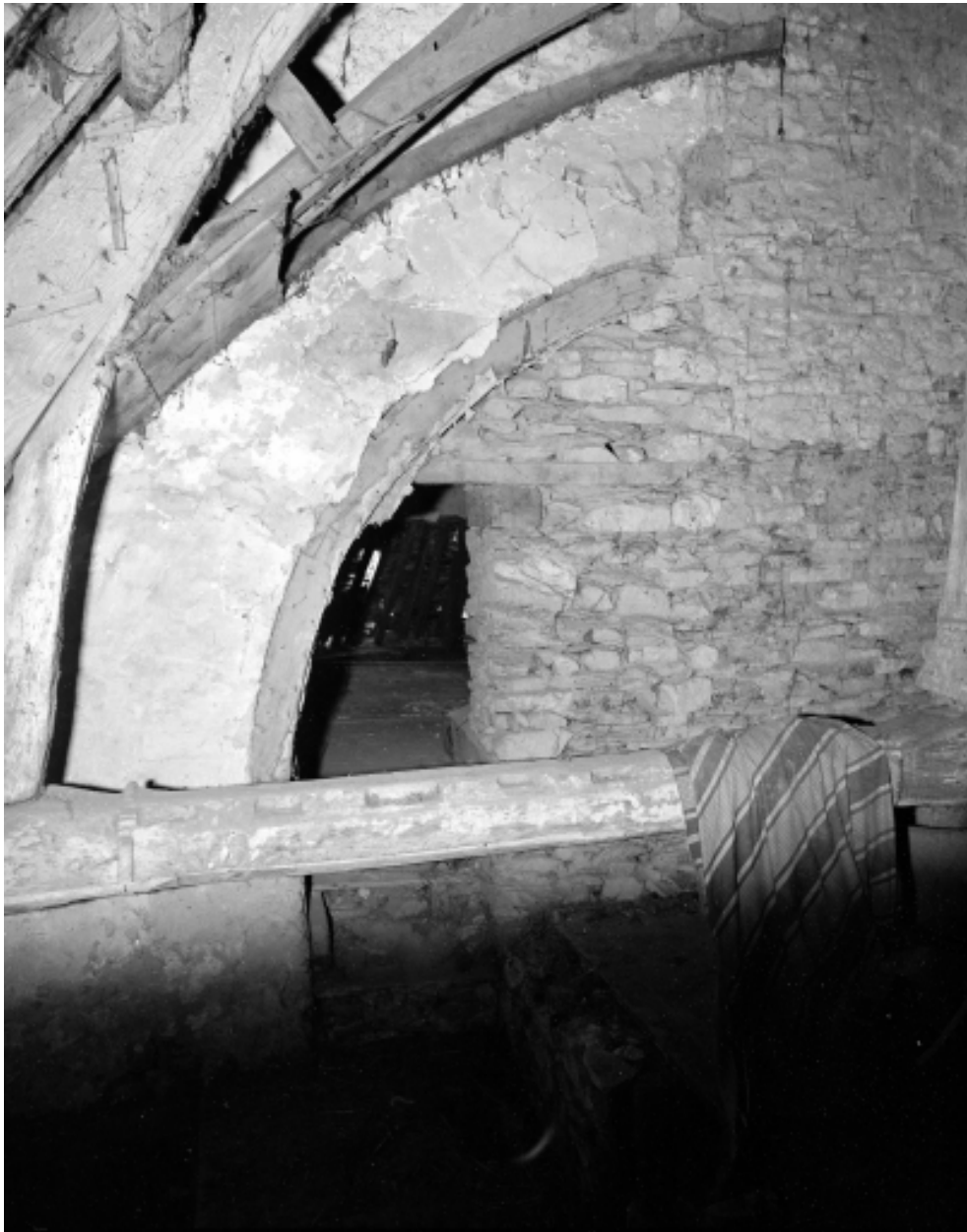
Détail de charpente.
